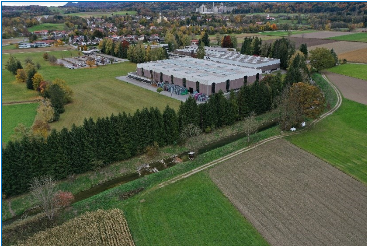
Abb. 1: An der Rohrdorfer Achen führt das Wasserwirtschaftsamt Rosenheim vorbereitende Rodungsarbeiten durch für die anschließende Sanierung und Ertüchtigung der Hochwasserschutzdeiche.
