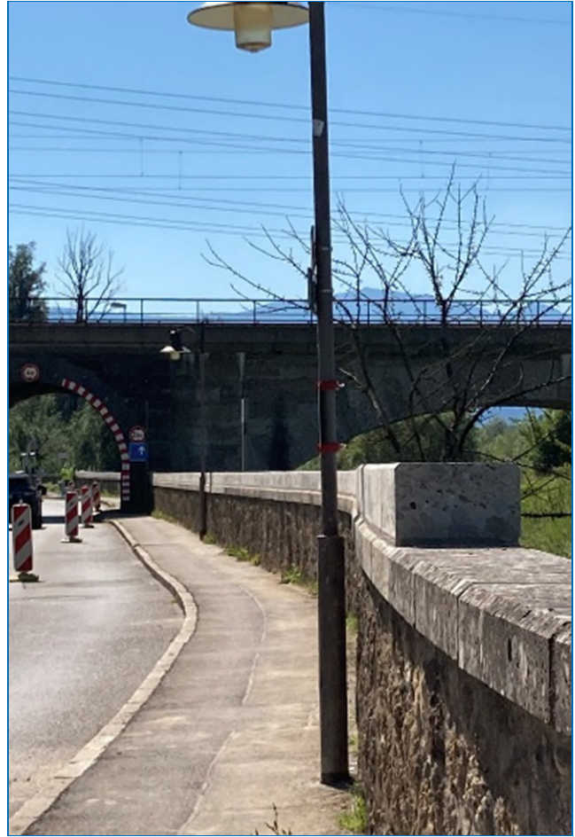
Abb. 2: Die Hochwasserschutzmauer im Bereich Hofleiten wurde mit Aufsatzsteinen erhöht – das aufmerksame Auge kann die Erhöhung heute noch erkennen (Foto: VERBUND)
