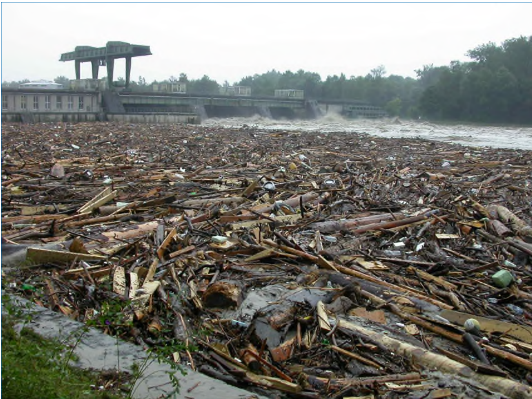
Abb. 3: Der Inn beim Hochwasser 2005 am Kraftwerk Rosenheim – auch der Umgang mit Treibholz stellt eine Herausforderung dar (Foto: VERBUND)
