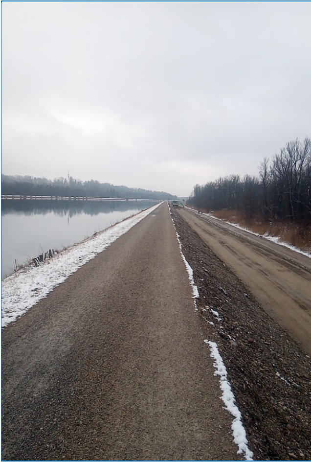
Abb. 1: Dammerhöhungen im Bereich Schechen – aktuell laufen ähnliche Maßnahmen im Bereich Thansau (Foto: VERBUND)
