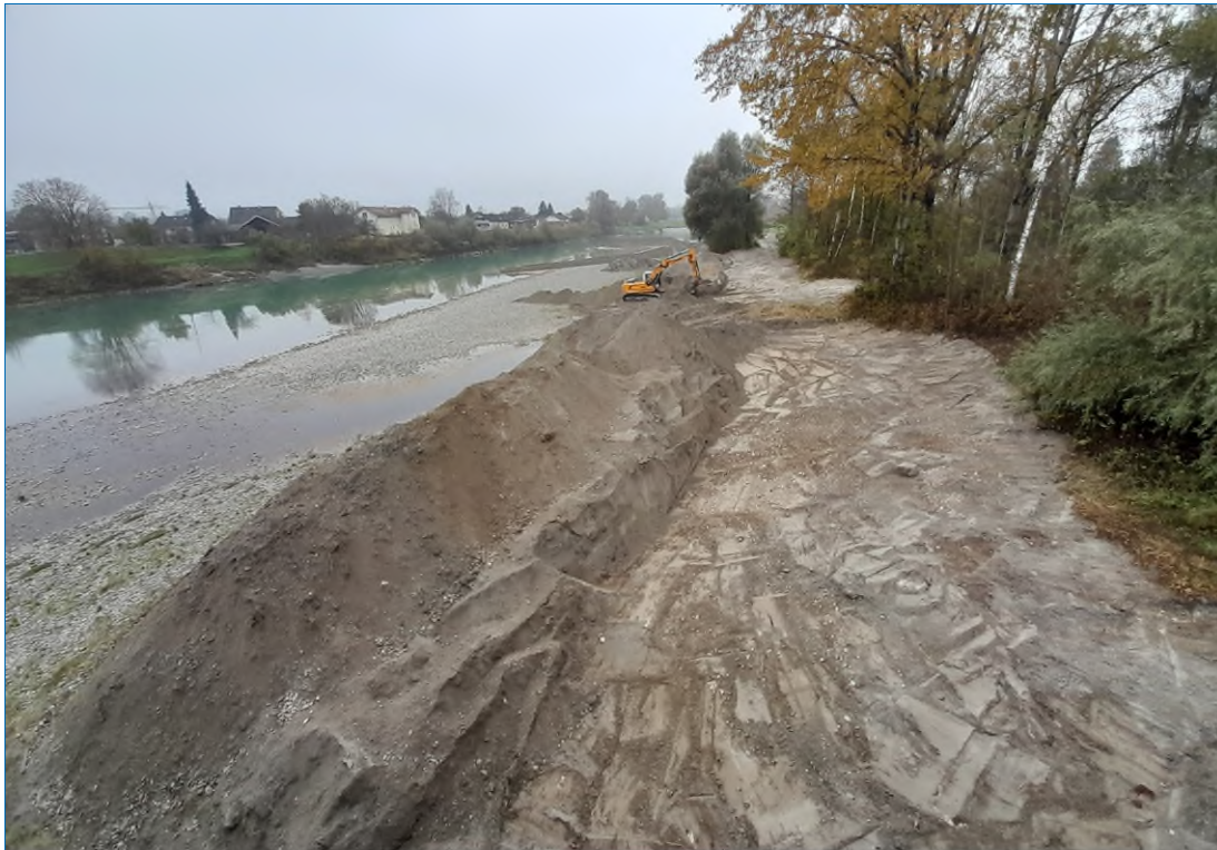
Abb. 2: Räumung der Flutmulde und des Vorlandes.
