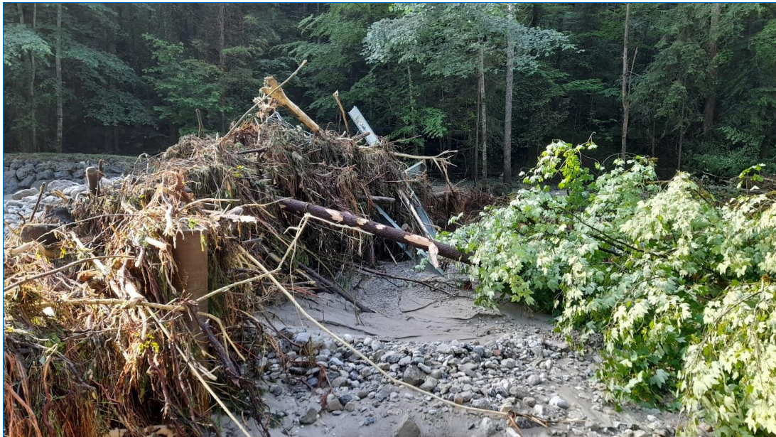
Der Wildholzrechen im Mühltal am 03.06.2024. All dieses Material wäre sonst in den Ortsbereich Nußdorf transportiert worden und hätte womöglich an Brücken und Engstellen Verklausungen verursacht.
