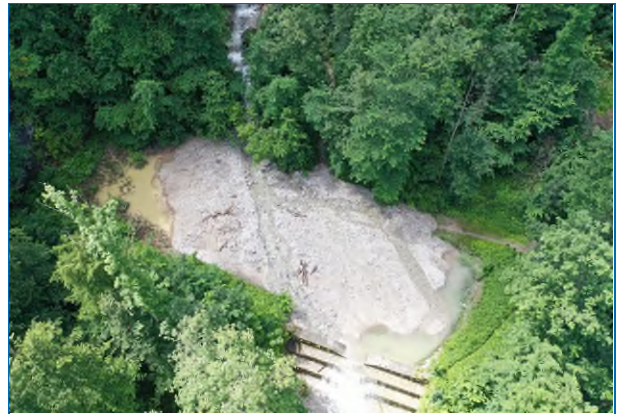
Abb. 83: Geschiebefälle am Maigraben – nach dem Ereignis (gefüllt mit ca. 700 m³)
