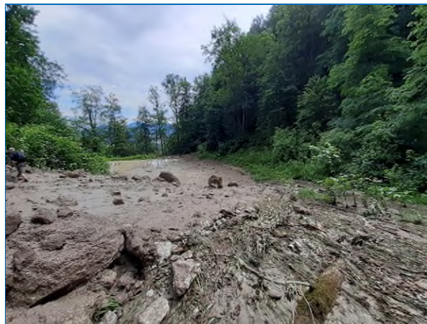
Abb. 85: Sperre Riesengraben – nach dem Ereignis
