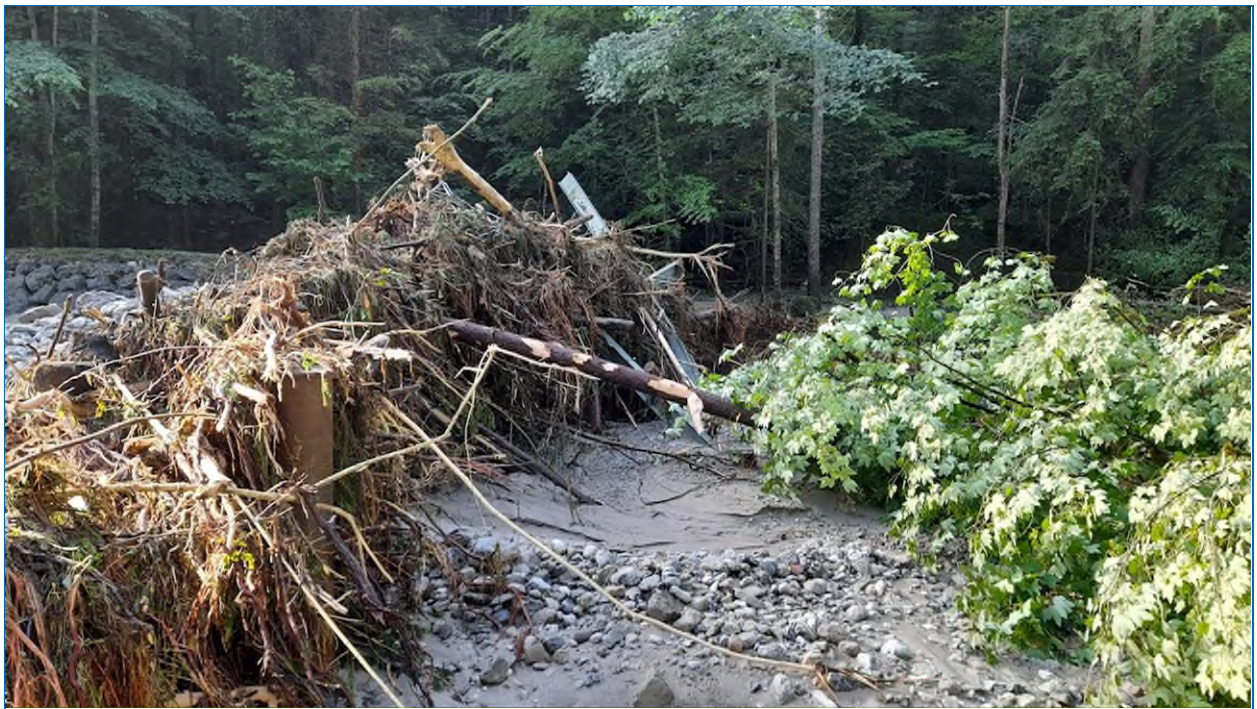
Abb. 51: Der Wildholzrechen am Steinbach oberhalb von Nußdorf nach dem Ereignis
