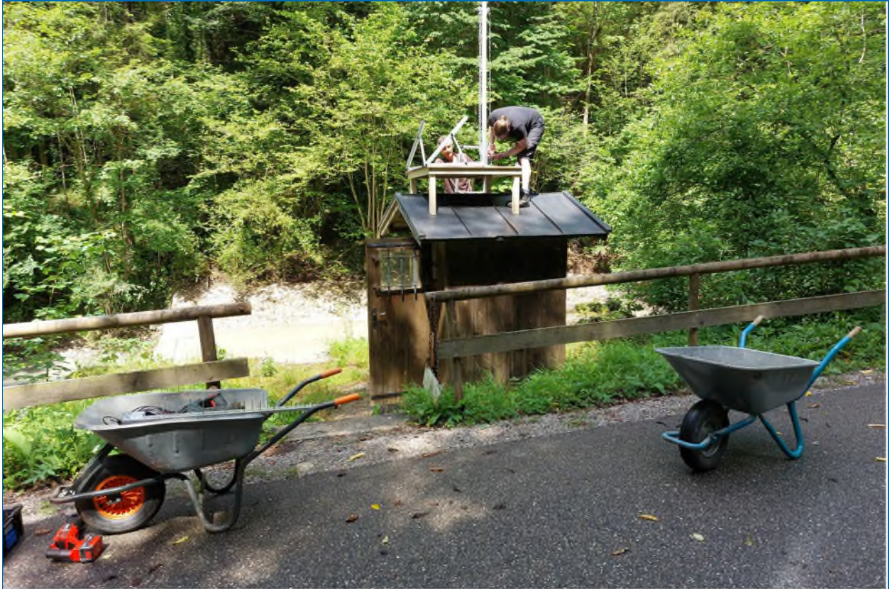
Abb. 56: Auch Schäden an Messeinrichtungen mussten repariert werden, so wie die Pegelanlage am Steinbach
