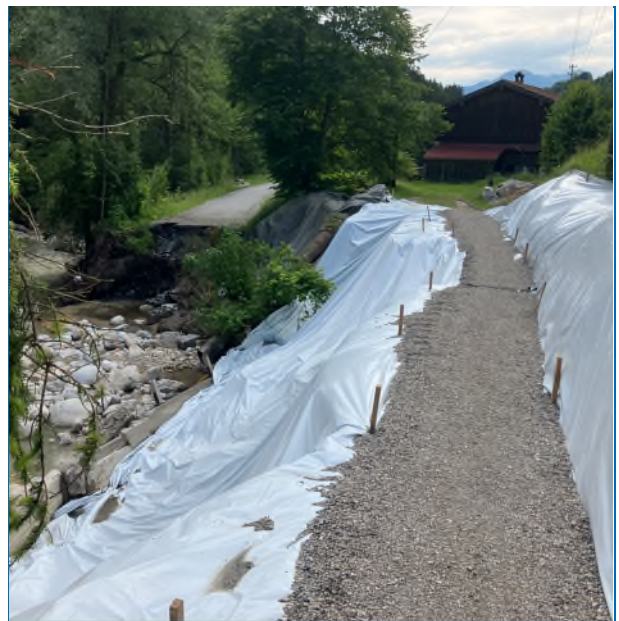
Abb. 47: Zugangsweg in das obere Mühlthal provisorisch hergestellt
