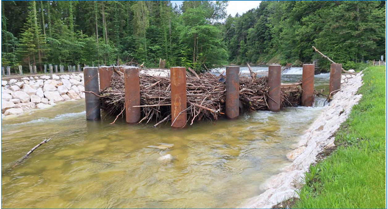
Abb. 67: Auch an der Prien erfüllte der neugebaute Wildholzrechen vor dem gleichnamigen Ort seine Funktion
