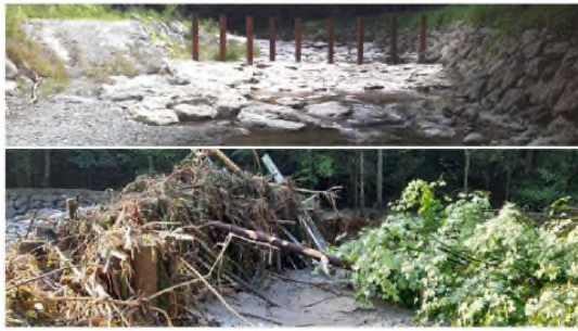
Der Wildholzrechen am Oberlauf des Steinbaches bei Nußdorf bei normaler Witterung (oben) und nach dem Unwetter vom 3. Juni. © Wasserwirtschaftsamt
