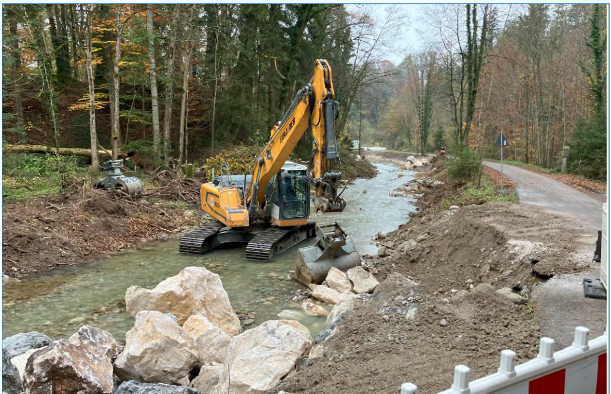
Abb.64: Uferbefestigung an der Rohrdorfer Ache wurde wiederhergestellt
