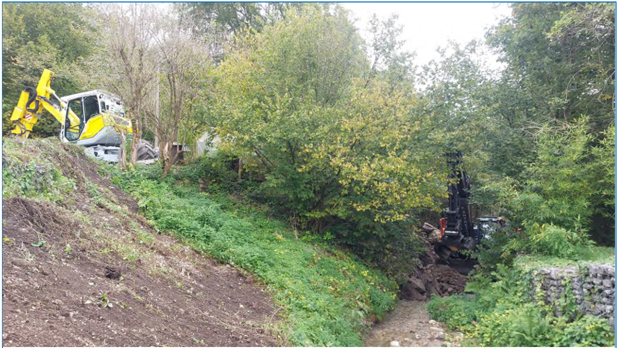
Abb. 58: Thannbach – Die Flussmeisterstelle Freising hilft mit Baggerfahrer und Schreitbagger aus (Danke !)
