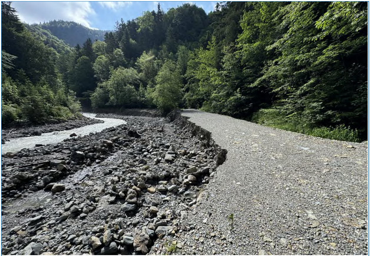
Abb. 74: Der Jenbach unterhalb des Brechries nach dem Ereignis
