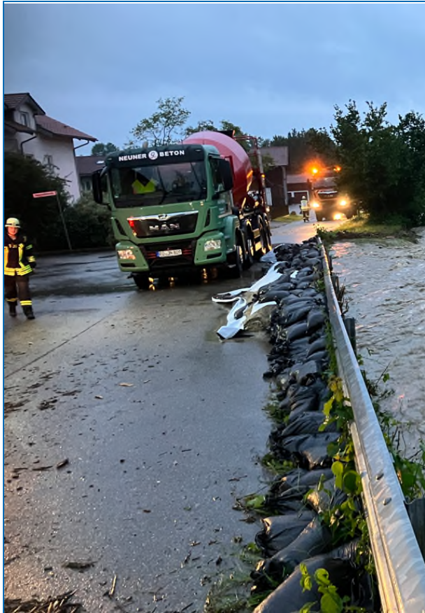
Abb. 61: Sandsackbarriere an der Rohrdorfer Ache – Rohrdorf
