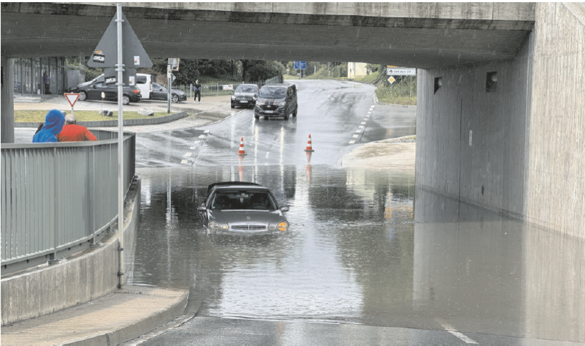
Eine Unterführung im niederbayerischen Wallersdorf stand am Donnerstag komplett unter Wasser.
