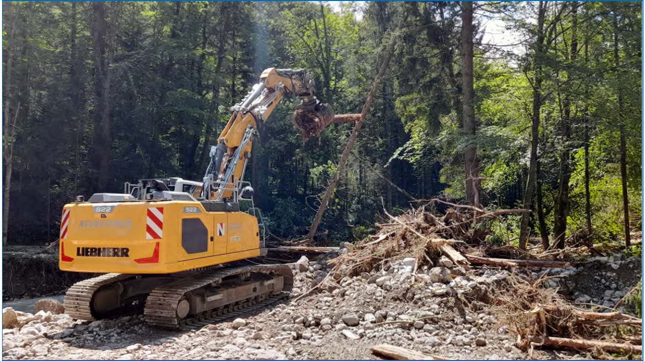
Abb. 52: Räumungsarbeiten am Wildholzrechen am Steinbach
