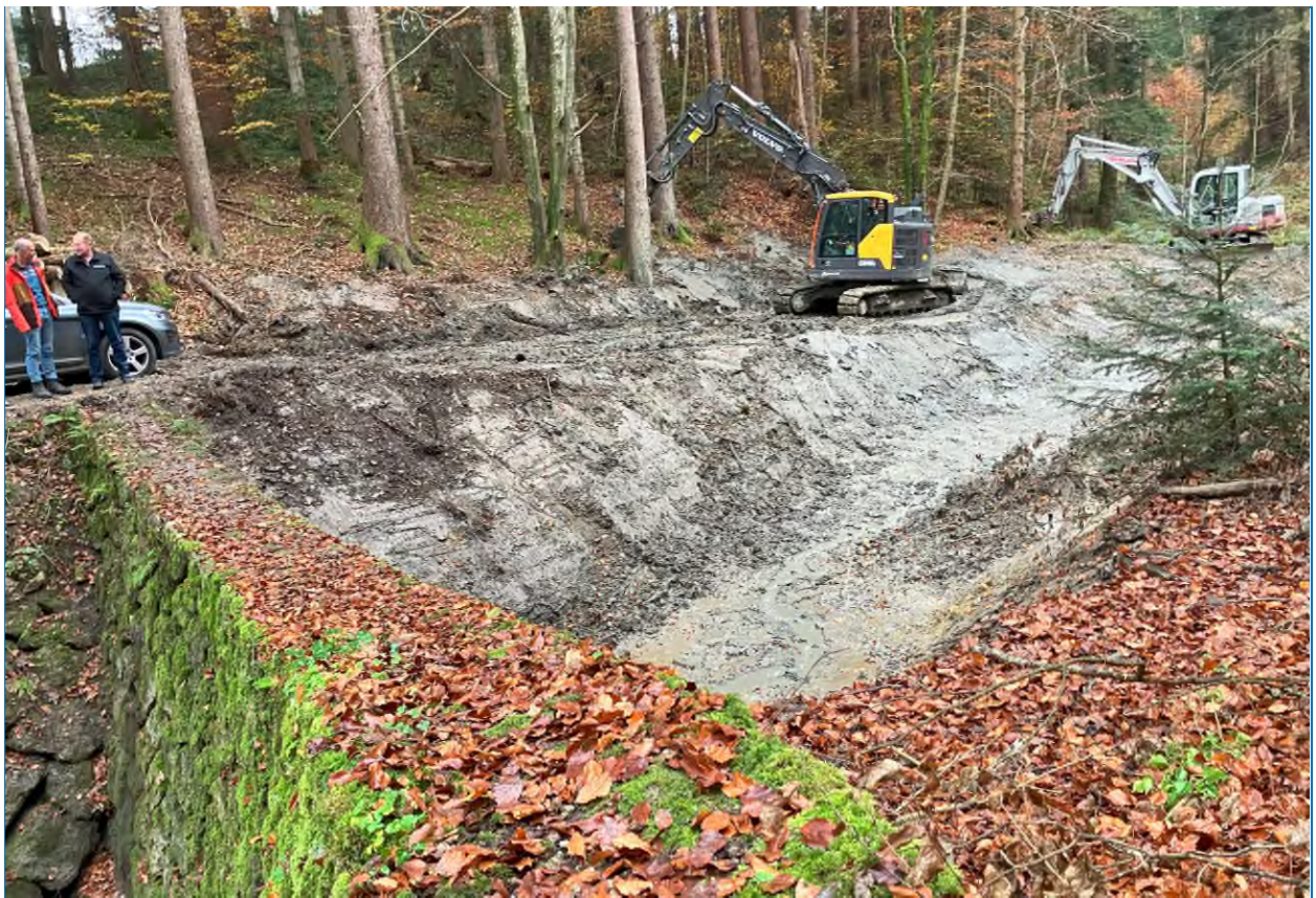
Abb. 59: Räumungsarbeiten am Möglgraben in Bernau
