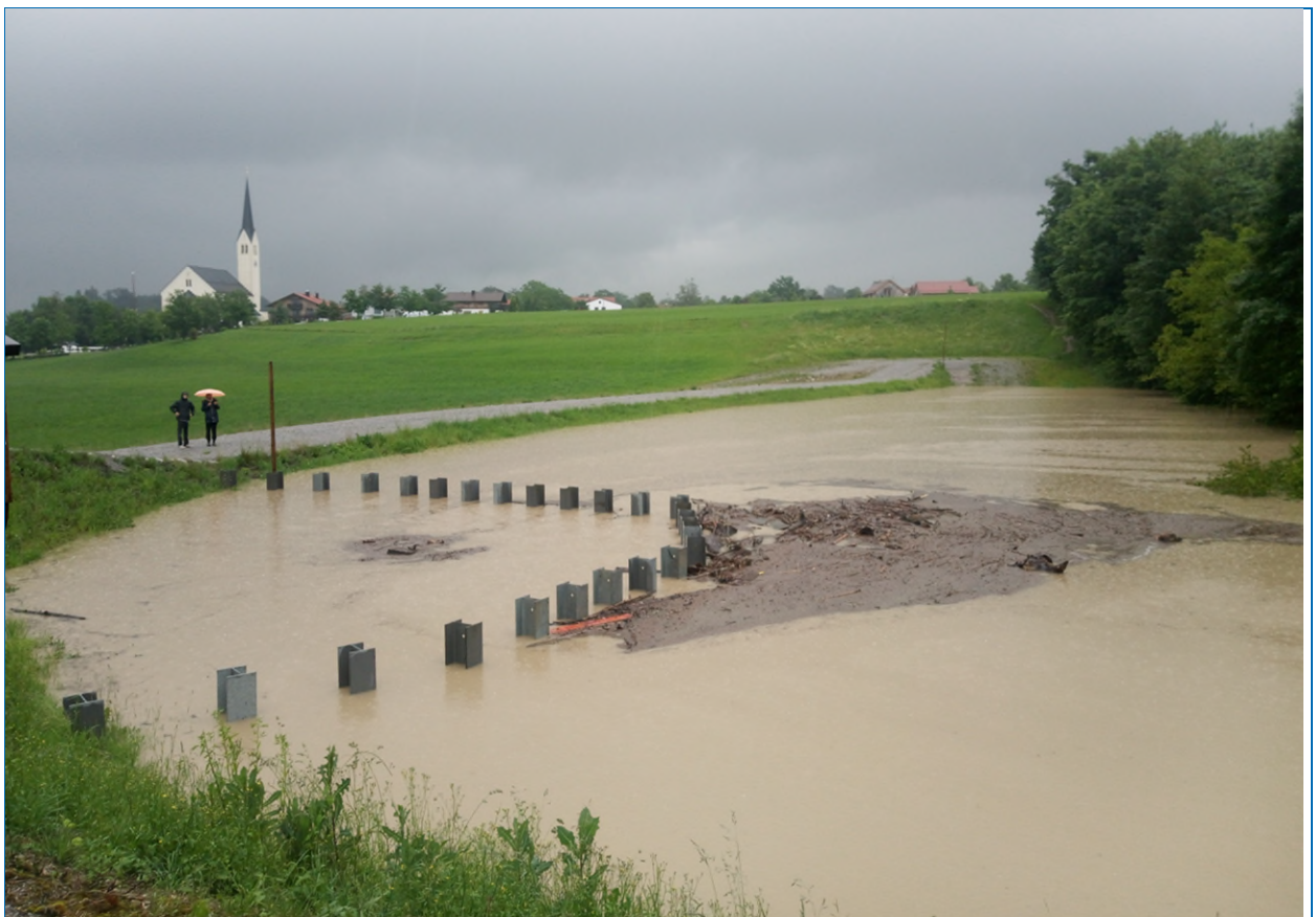
Abb. 68: Das Rückhaltebecken am Rothbach kurz vor dem Anspringen der Hochwasserentlastung – Riedering
