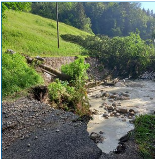
Abb. 46: oberes Mühlthal, Blick von unterstrom
