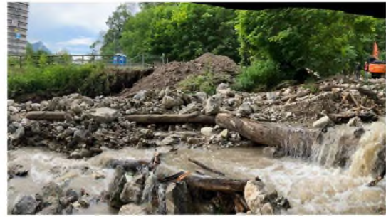
Die Zerstörungen einer Nacht: Die Sanierungsarbeiten am Steinbach in Nußdorf haben begonnen. Erosierte Böschungen am Bachlauf und die Ortsverbindungsstraße von Nußdorf nach Samerberg müssen wieder aufgebaut werden. © Wasserwirtschaftsamt
