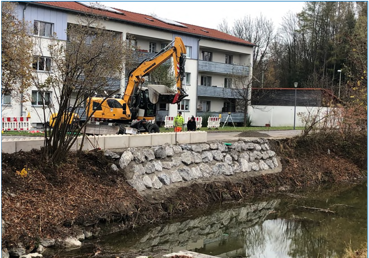
Abb. 63: Sofortmaßnahmen an der Wolfsgrubenstraße – Rohrdorf
