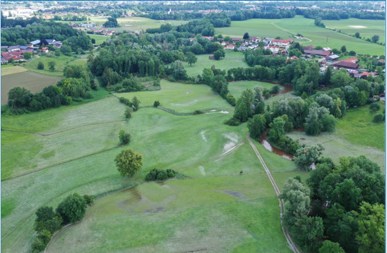
Abb. 77: Überflutungsflächen des Kaltenbachs zwischen Pösling und Hohenofen
