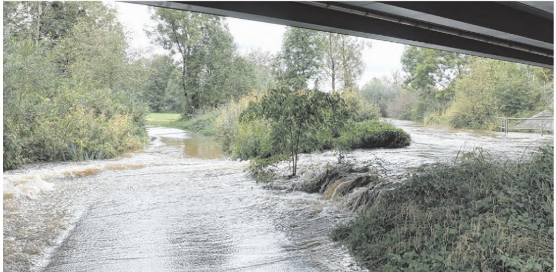
Überflutung durch die Kalten im Bereich der Westtangente.
