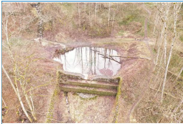
Abb. 82: Geschiebefälle am Maigraben – vor dem Ereignis (leer)
