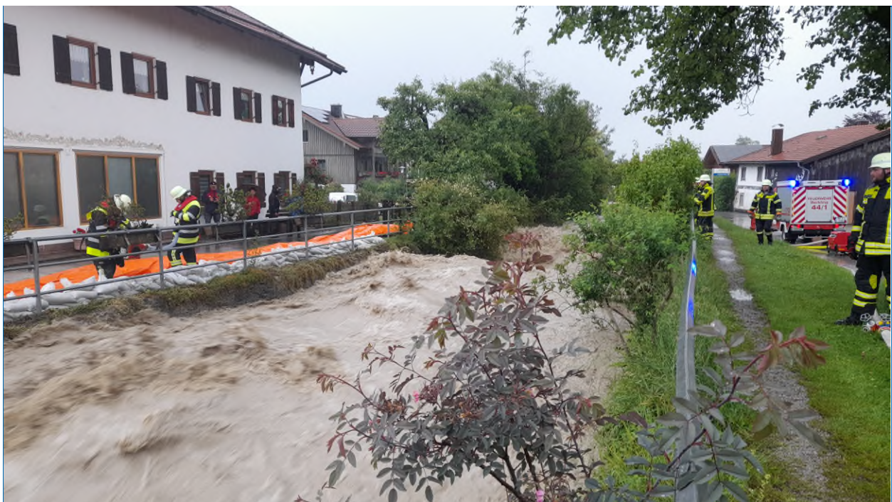
Abb. 71: Am Aubach in Au baut die Feuerwehr einen Damm aus Sandsäcken, um ein Ausufern des Bachs zu verhindern
