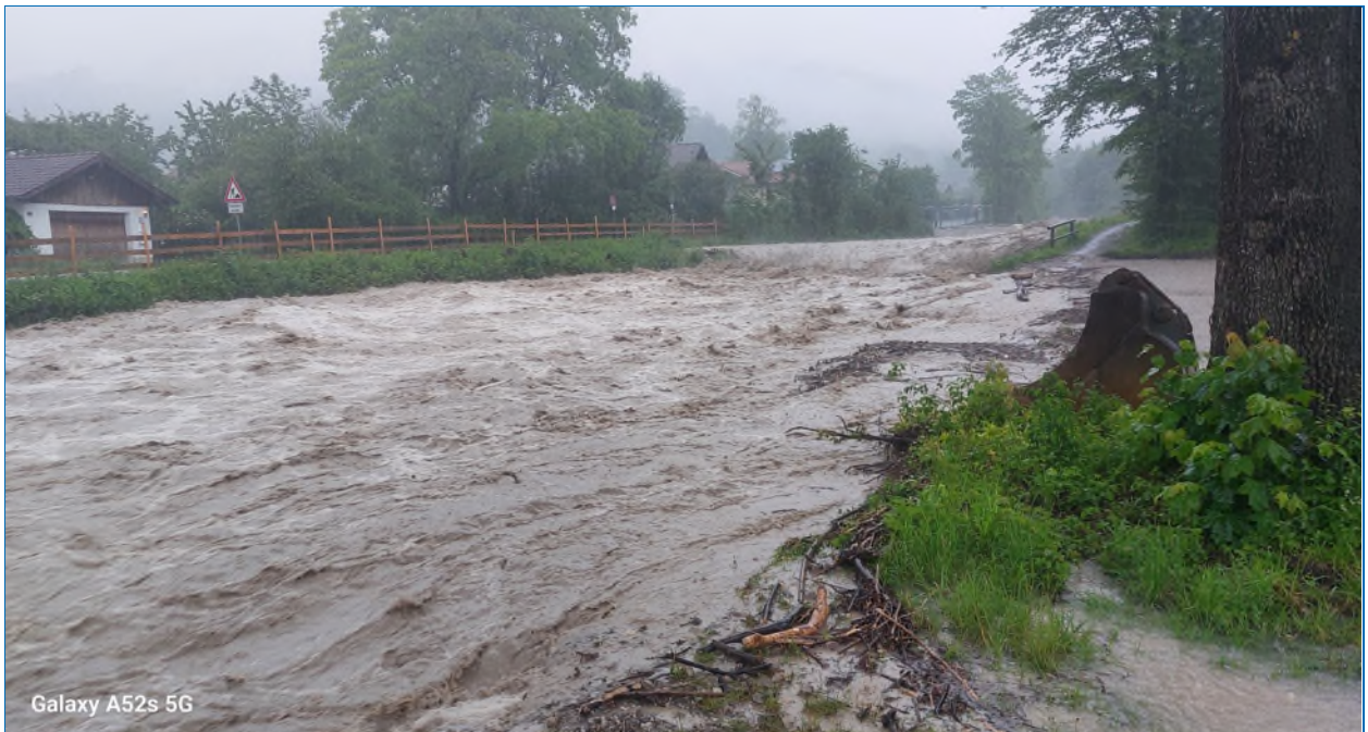
Abb. 49: Der Ausbau des Steinbachs in den letzten Jahren verhinderte im Ortsbereich von Nußdorf Schlimmeres
