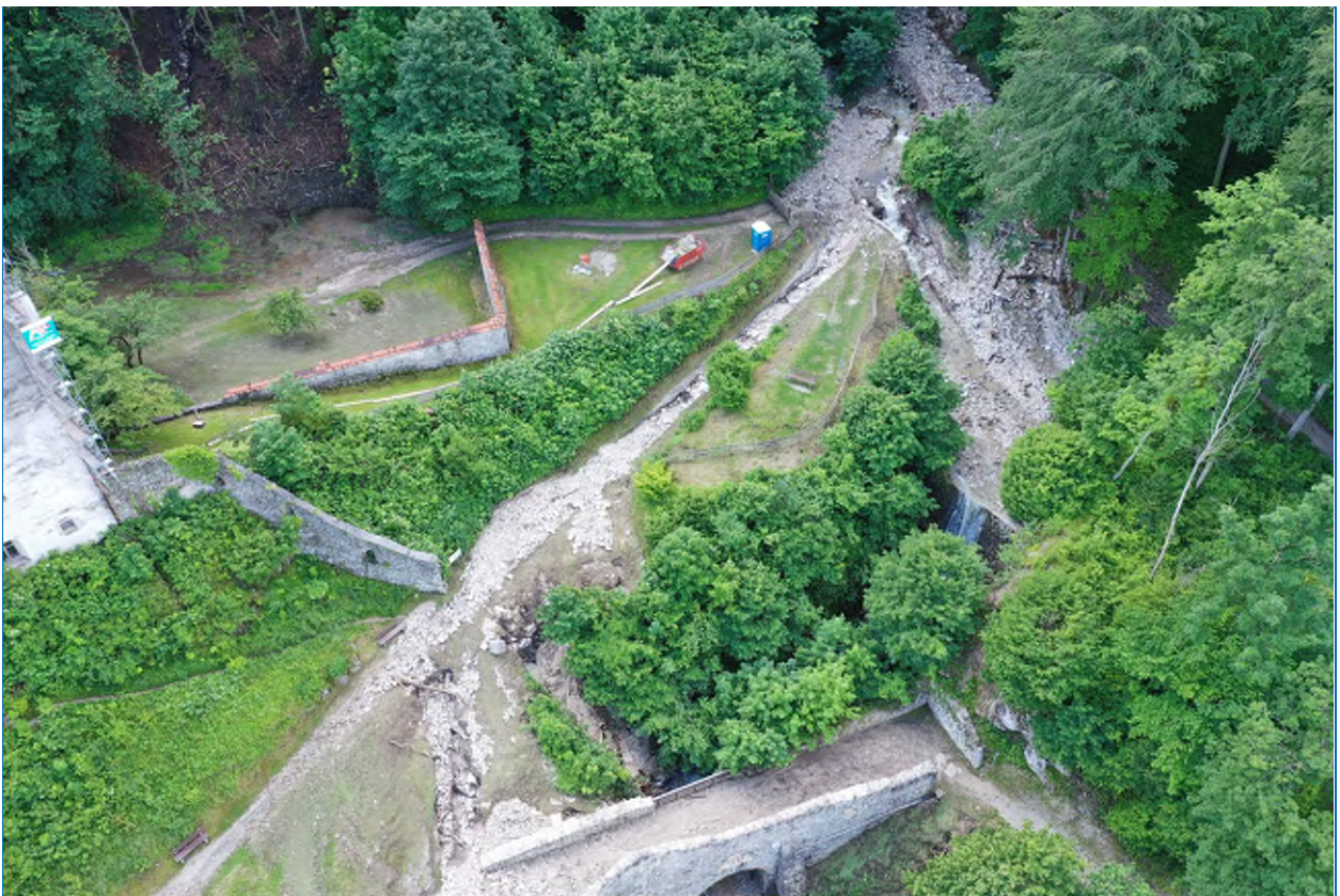
Abb. 78: Der Weg des Hundsggrabens in die Burgruine Falkenstein nach Verlegung seines Bachbetts – Flintsbach
