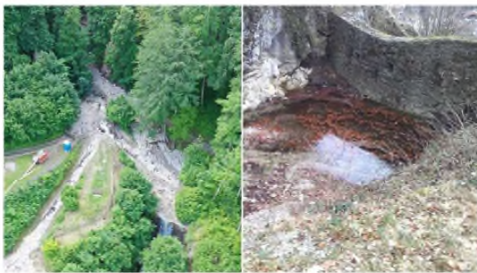
Eine Luftaufnahme des Hundsgrebs oberhalb der Burg Falkenstein in Flintsbach zeigt das Geröll, das die Geschiebesperre am 3. Juni innerhalb kürzester Zeit füllte. Etwa 50 Meter oberhalb brach der Bach aus seinem Bett aus und stürzte mitten durch die Burg Falkenstein bergab. Das Foto rechts zeigt die Geschiebesperre im „Normalzustand“. © Wasserwirtschaftsamt
