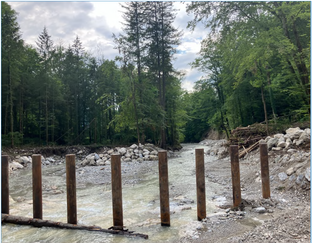
Abb. 53: Der Wildholzrechen am Steinbach nach der Räumung
