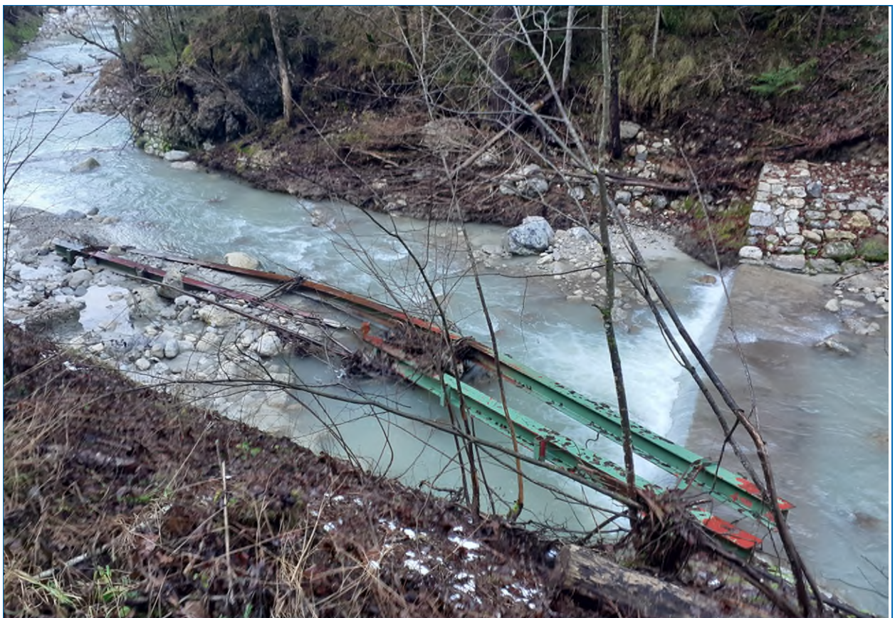
Abb. 57: Pegel Nußdorf – Steinbach: Die Eisenträger des Messstegs im Bachbett
