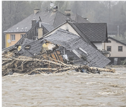
Eingestürzte Häuser am über die Ufer getretenen Fluss Bela nach schweren Regenfällen in der Stadt Jeseník. DIVISEK/EPA
