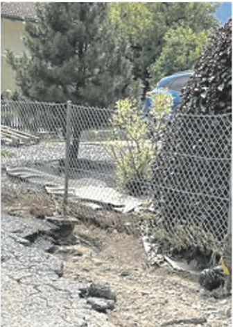
Achenmühle am 3. Juni 2024: In diesem Bereich unterspülte die Wucht der Flut die Straße, zerstörte Untergrund und Deckschicht. Der Hochwasserschutz des Ortes gehört zu den wichtigsten Projekten der kommenden Jahre.
