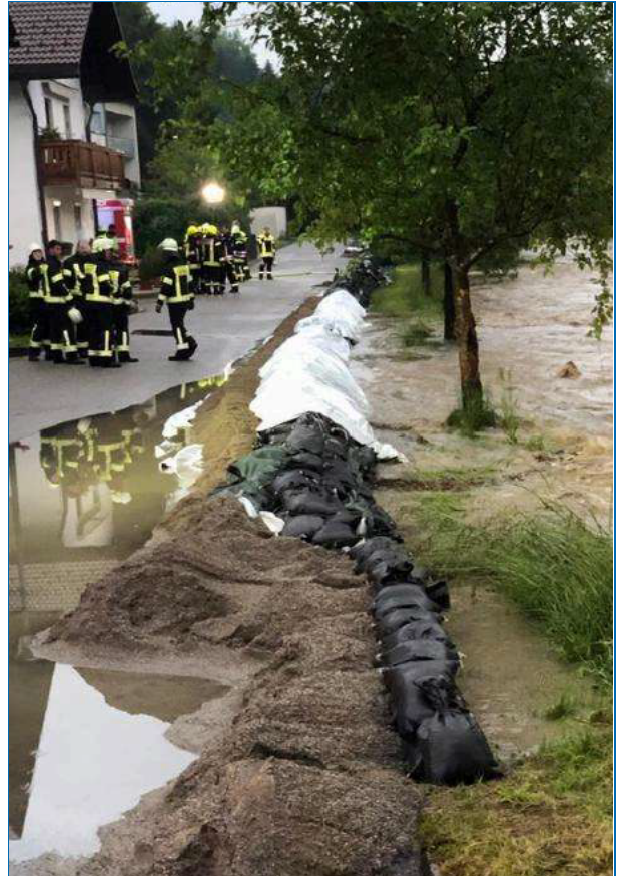
Abb. 62: Rohrdorfer Ache – Die Feuerwehr verteidigt an der Wolfsgrubenstraße - Rohrdorf
