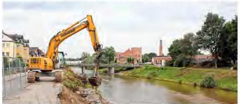
Die ersten Arbeiten haben begonnen: Nach den Rodungsmaßnahmen wird nun die ausgespülte Uferböschung auf der Südseite der Mangfall im Innenstadt-Bereich von Kolbermoor mit Felsbrocken verstärkt.
