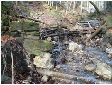
zerstörte Steinsperre am Rißbach
