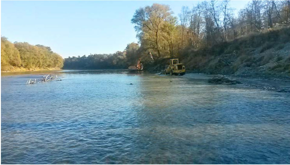
Foto WWA RO: Baggerarbeiten Steinentnahme am Inn
