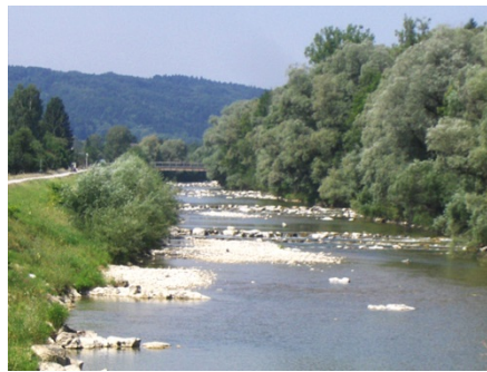
Bewuchs im Vorlandbereich Bruckmühl
