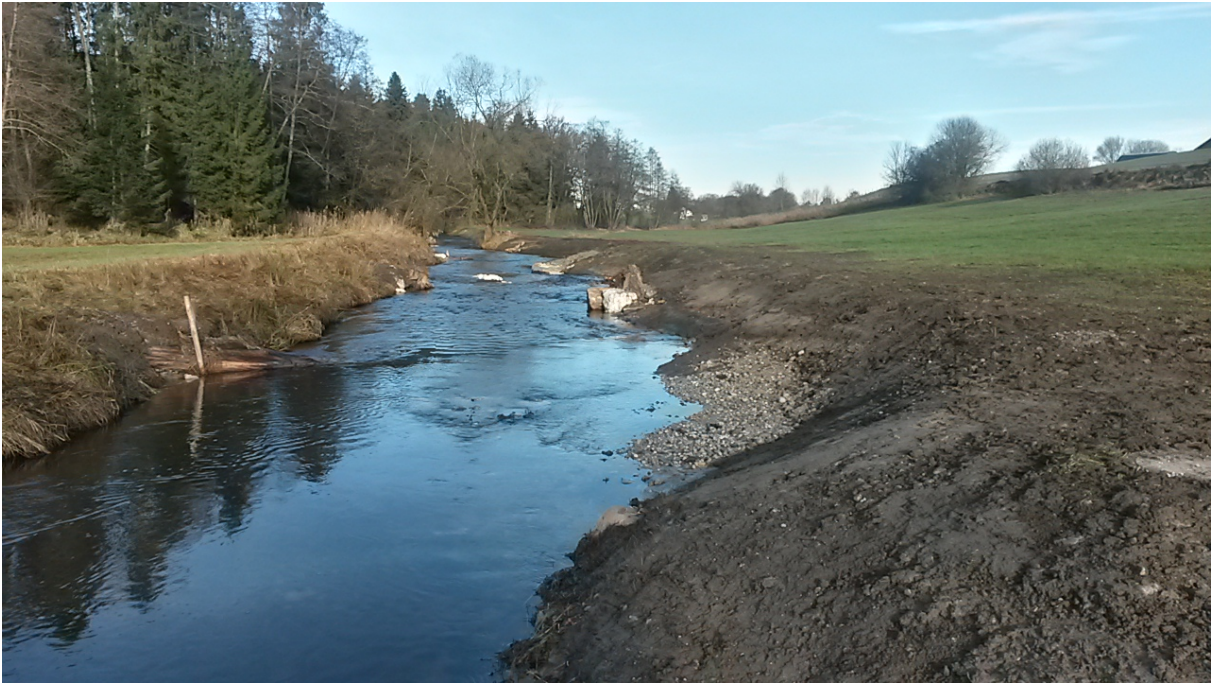
Foto WWA Ro: umgestalteter Teilabschnitt
