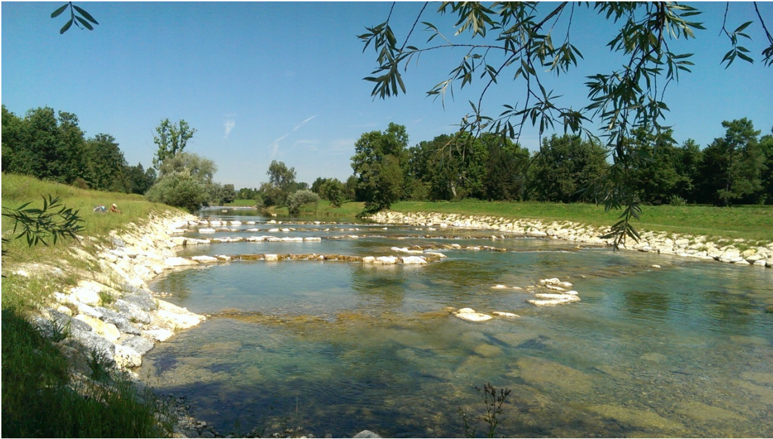
Hochwasserdeich mit umgebauter Rampe in Bruckmühl 2014
