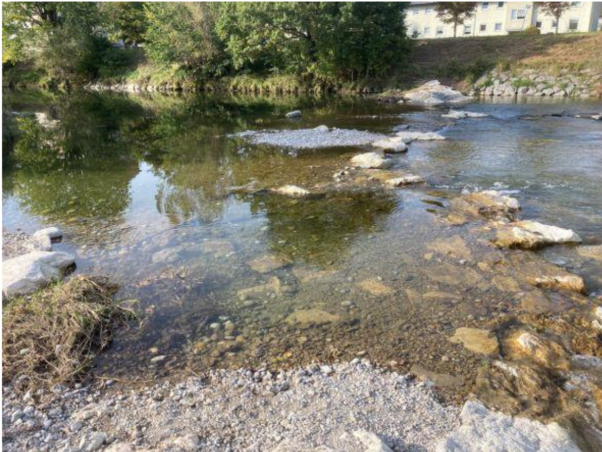
Abb. 1: Bereits umgebaute Sohlrampe am Turnersteg (Foto: WWA Rosenheim)
