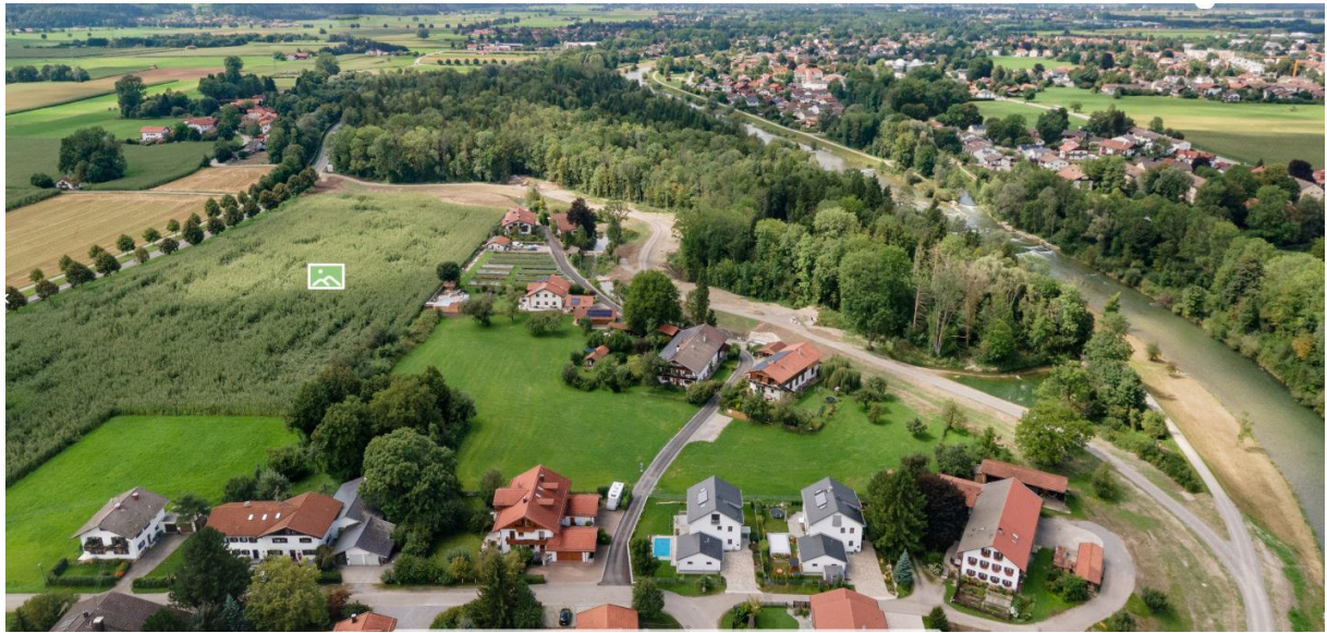
Abb. 1: Der neue Hochwasserschutzdamm westlich der Pullacher Au. Am linken oberen Bildrand wird nun die Hochwassermauer entlang des Auwalds und der St 2078 gebaut.
