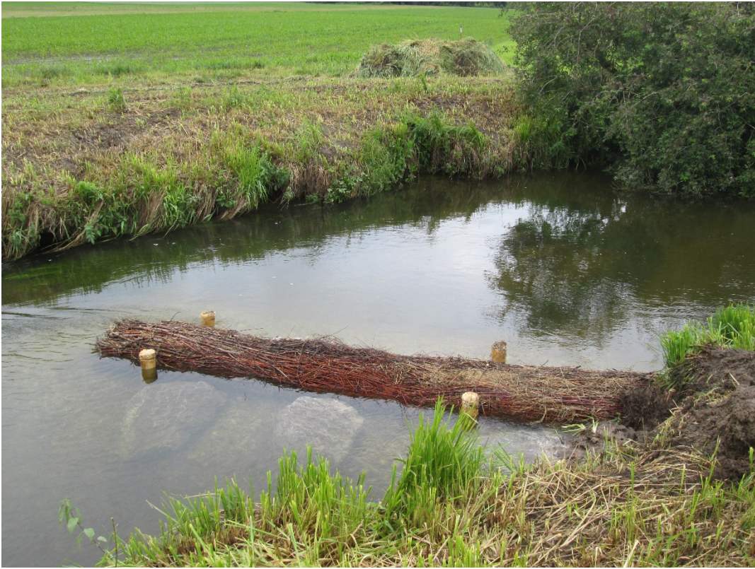
Senkfaschine in der Glonn (Bild: WWA Rosenheim)
