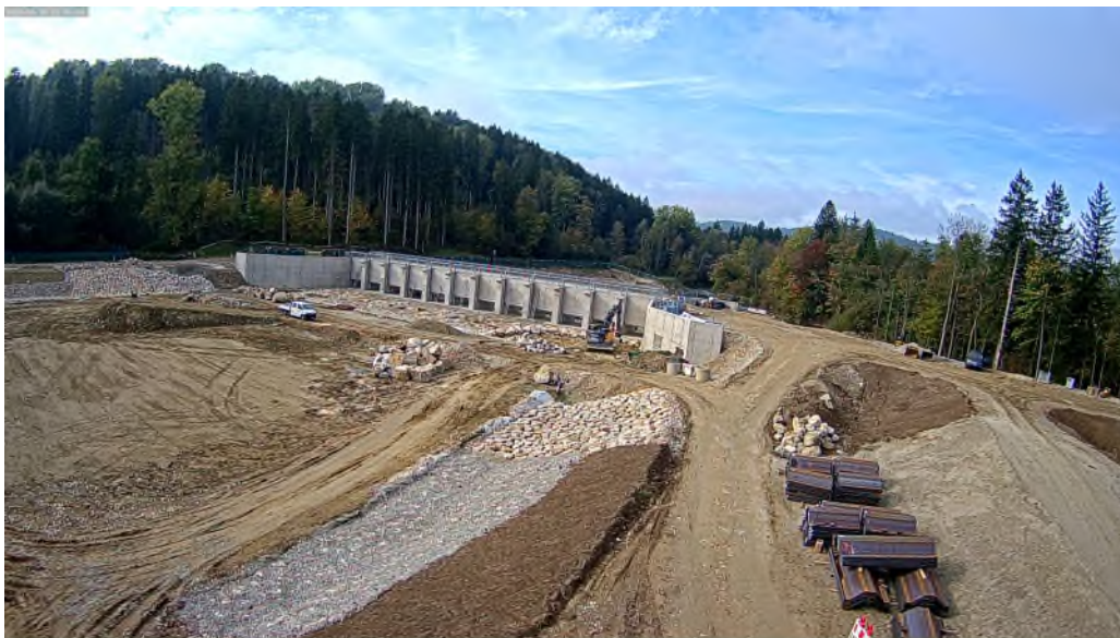
Abb. 1: Sperrung der Durchfahrt am Einlassbauwerk (Foto Baustellenkamera) für 3 Wochen
