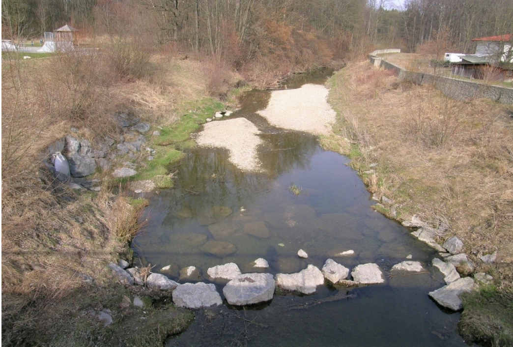
Abb. 1: Die Aufnahme aus dem Jahr 2008 zeigt den Kalten-Auerbach unterstrom der Brücke Turnerweg; Nähe Wertstoffinsel / Skaterpark. Der Siedlungsbereich von Oberwöhr rechts des Auerbachs wird durch einen Hochwasserdeich und eine Hochwasserschutzmauer vor Überflutungen geschützt. Die Böschungen sind mit einzelnen Stauden und Gehölzen bewachsen.
