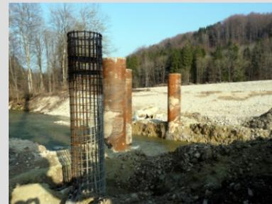
▲ Die ausbetonierten Stahlrohre sind notwendig, um dem Anprall der Baumstämme zu widerstehen
