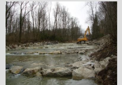
▲ Einbau der Wasserbausteine zu einer naturnahen Rampe
