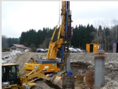
▲ Die Bohrpfähle gehen bis in eine Tiefe von 9 Metern und dienen der Verankerung
