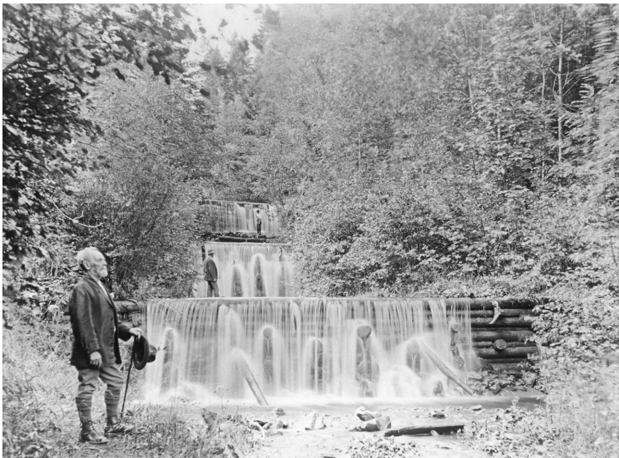
Abb. 2: historische Aufnahme: Bau von Holzkastensperren am Osterbach in Bad Feilnbach
