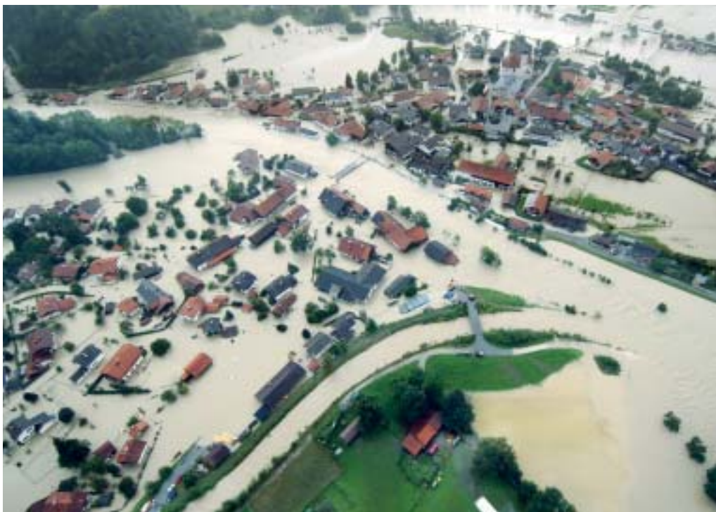
Der oberbayerische Ort Eschenlohe an der Loisach war besonders vom Hochwasser 2005 im nördlichen Alpenraum betroffen.
